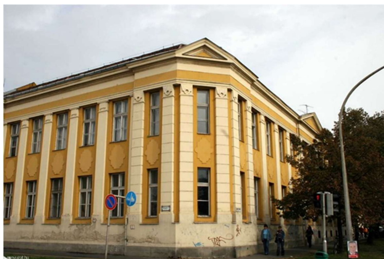
(VVSZC Hefele Szakképző Iskola homlokzat)
