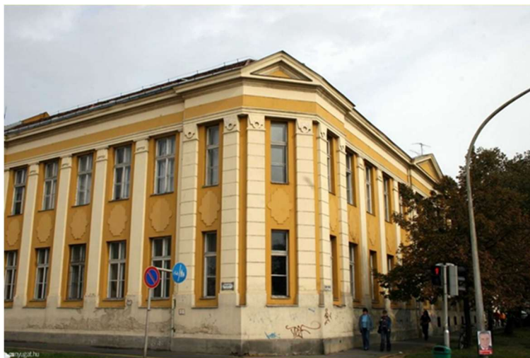
(VMSZC Hefele Szakképző Iskola homlokzat)
